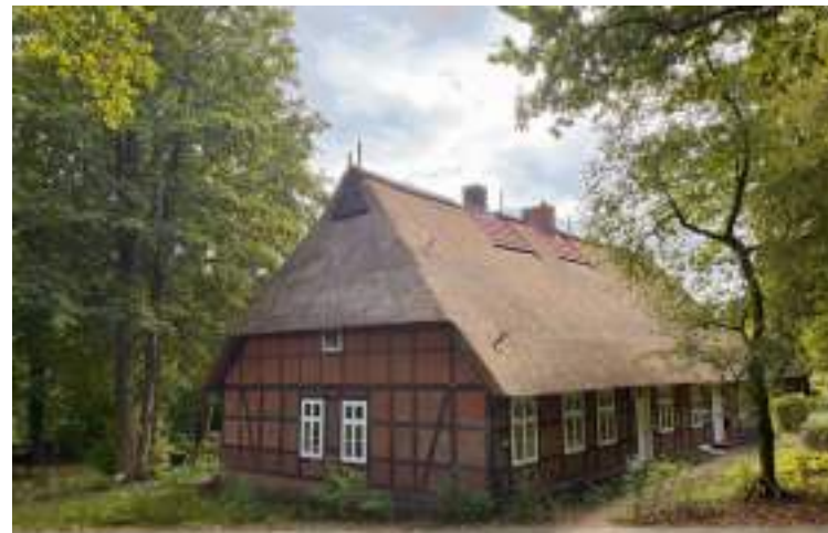
Das neue Reetdach ist ein Hingucker!
